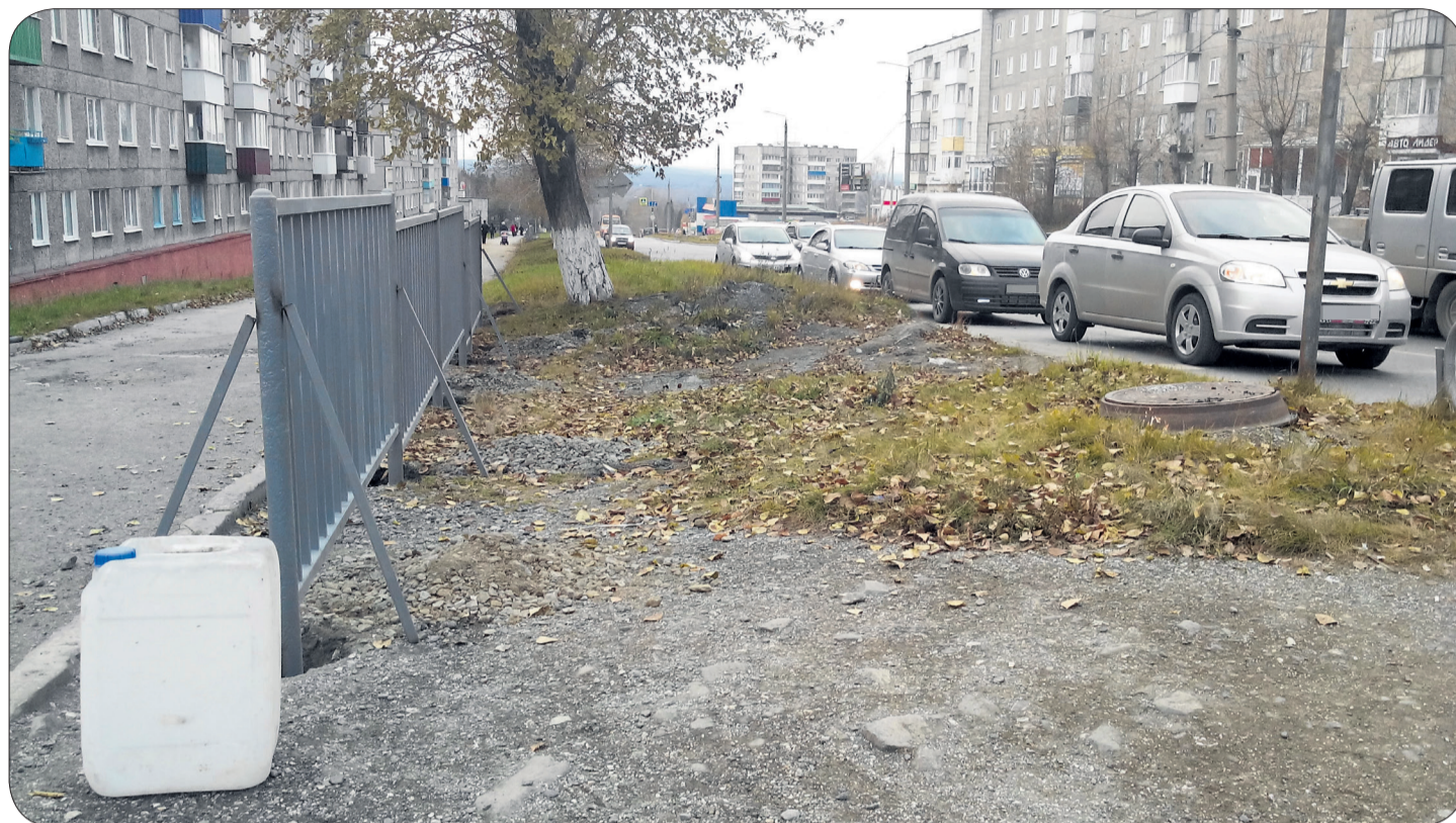
■ На перекрестке у «Кедра» ведут работы по установке удерживающих ограждений. Ставят у тротуара. При работах по реконструкции улицы от газона избавятся
